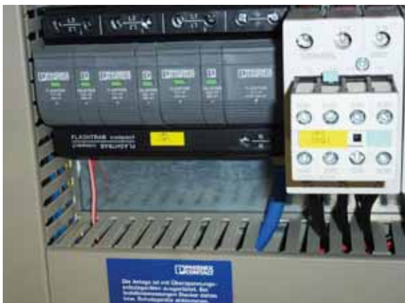
Bild 18: Überspannungsableiter
