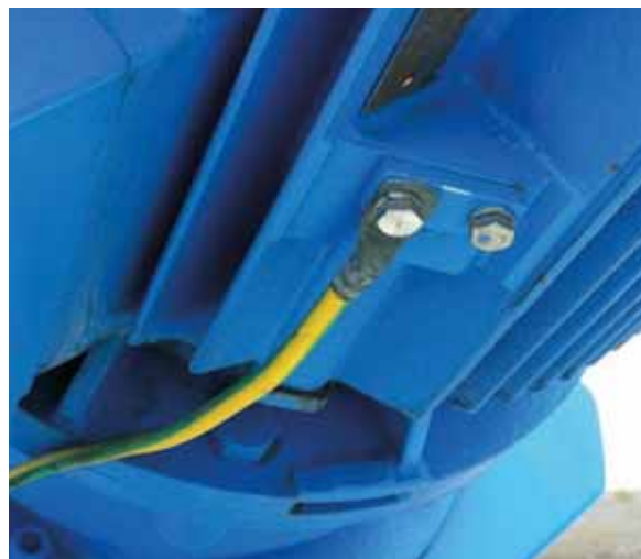
Bild 21: Potentialausgleich am Rührwerksmotor
