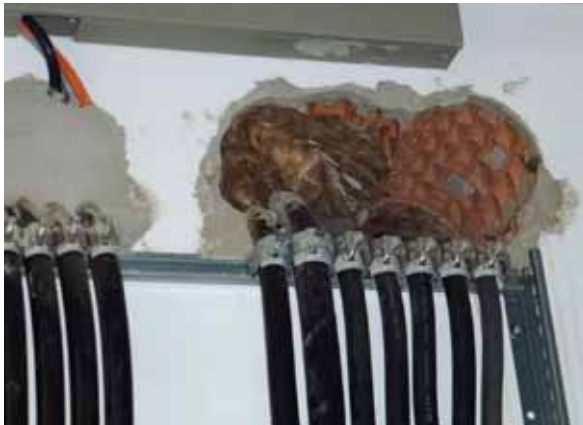
Bild 24: Mangelhafte Kabeldurchführung
