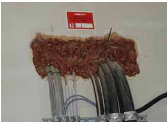
Bild 25: Bauaufsichtlich zugelassene Kabeldurchführung
