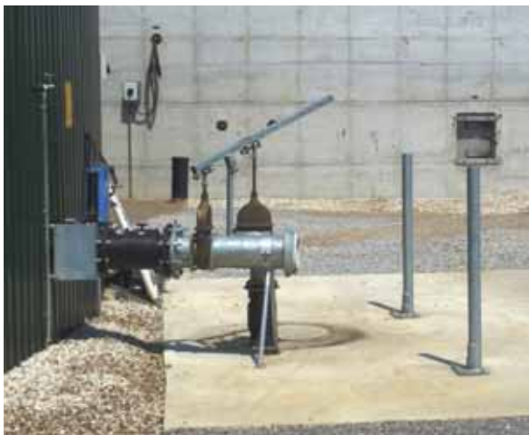
Bild 5: Doppelter Sperrschieber mit Sollbruchstelle
