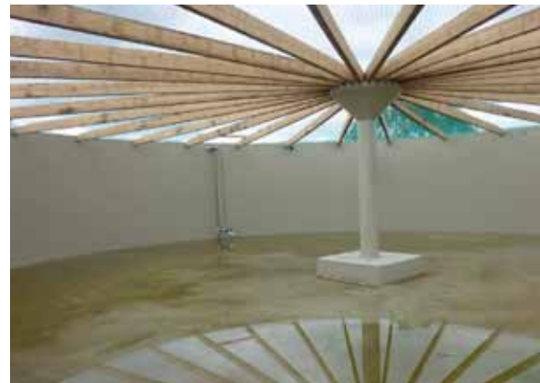
Bild 6: Holzkonstruktion im Nachgärer
