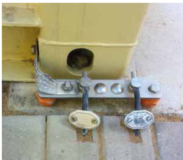
Bild 20: Einbindung von Anlagenteilen in den vermaschten Potentialausgleich
