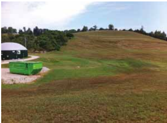
Bild 3: Biogasanlage am Fuß eines Hanges
