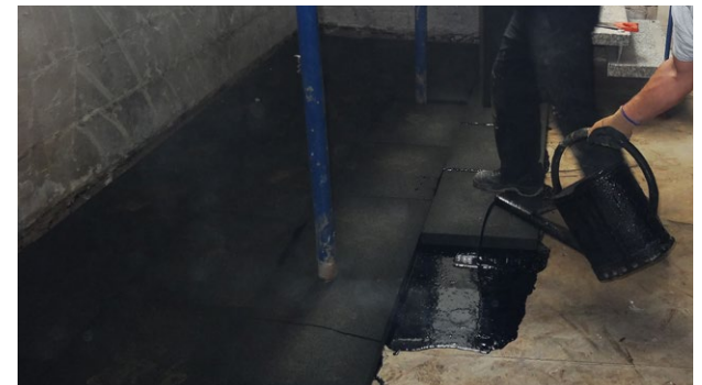
Schaumglasverlegung in Heiðbitumen
