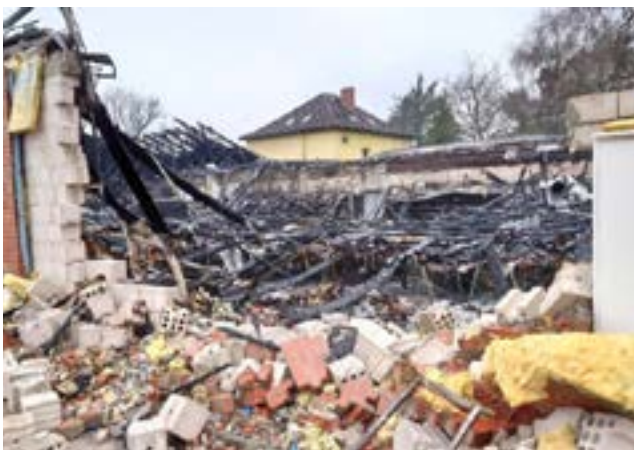
Beispiel eines vom Feuer total zerstörten Supermarkts (Quelle: A. Küsel)
