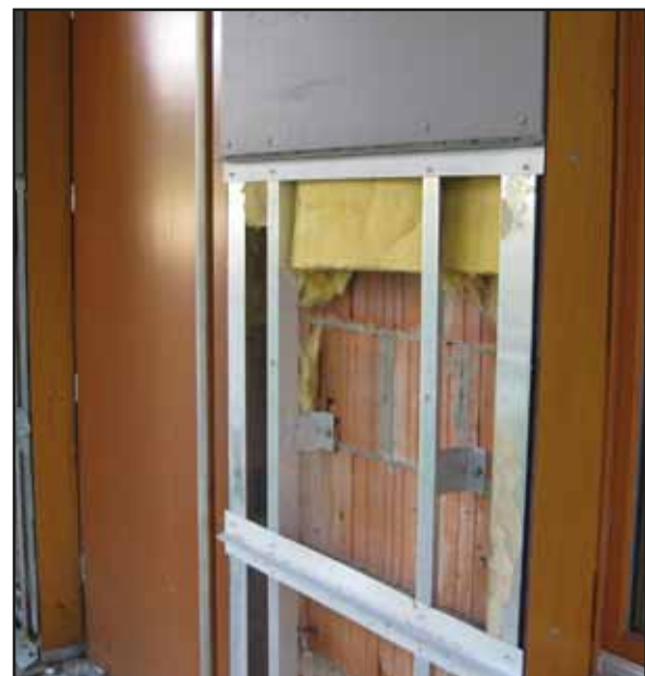
Abb. 6: Vorgehängte hinterlüftete Fassade (© HTW Dresden)
