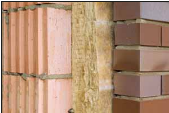
Abb. 5: Zweischaliges Mauerwerk mit Kerndämmung (Mineralwolle) (© HTW Dresden)
