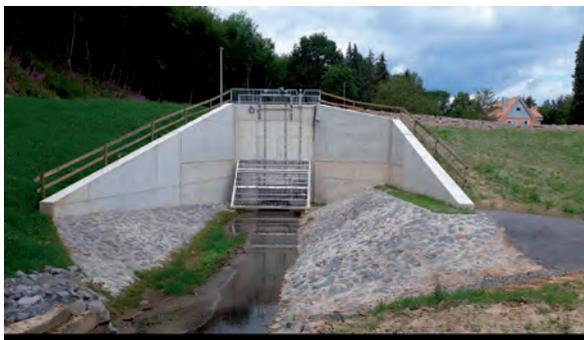
**Abb. 8-29:** Durchlassbauwerk, Blick talab (Quelle: W. Schleiner)
