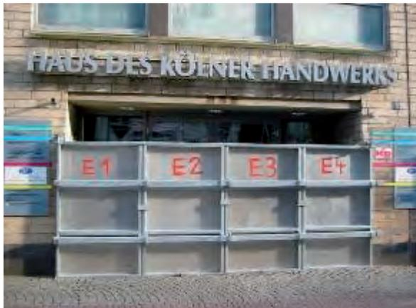
**Abb. 7-2:** Beispiel mobiler Hochwasserschutzzelemente (Quelle: B. Falkenhagen)
