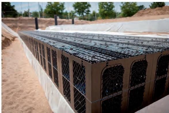
**Abb. 8-24:** Beispiel einer Versickerungsanlage (Quelle: Rehau)
