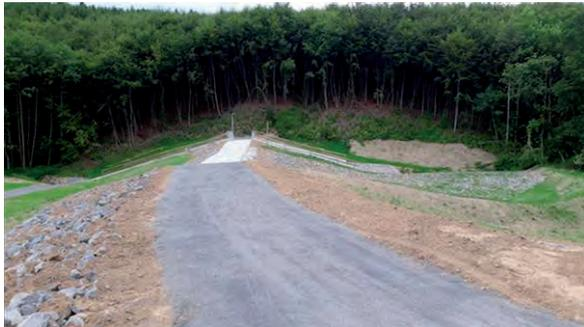
**Abb. 8-28:** Dammkrone zwischen den Flanken des Jabachtals, mit Notüberlauf und Durchlassbauwerk (Quelle: W. Schleiner)
