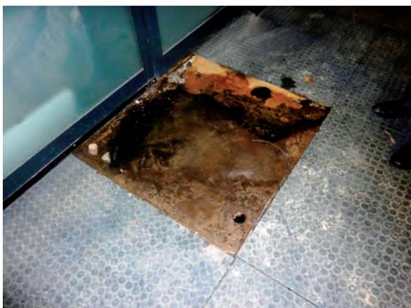
**Abb. 8-22:** Feuchtigkeit unter Bodenbelag (Quelle: Gotthardt Bausachverständige)
