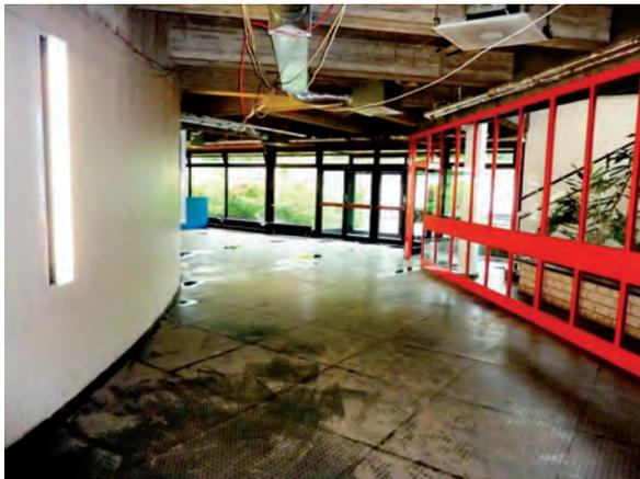
**Abb. 8-21:** Überschwemmung Foyer/Flur im Untergeschoss (Quelle: Gotthardt Bausachverständige)
