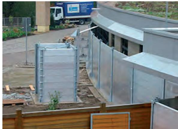
**Abb. 8-17:** Einbindung von Sonderbauwerken außerhalb der Hauptschutzwand (Quelle: RS Stepanek OHG)
